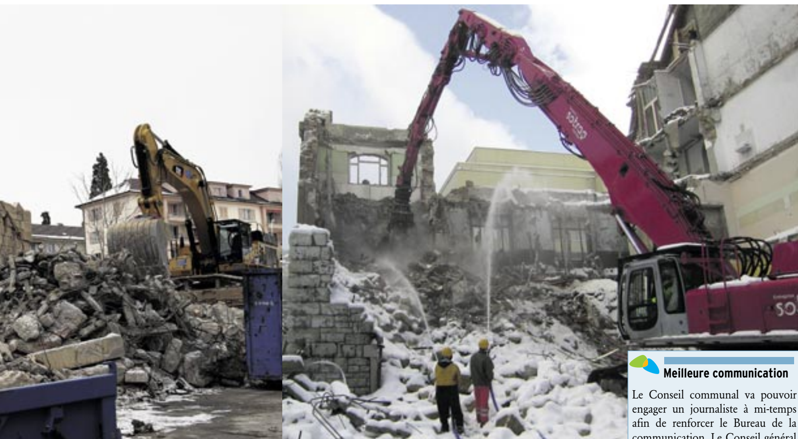
démolition de l'ancien collège bientôt remplacé par Microcity constitue l'un des investissements importants de la Ville en 2011.
