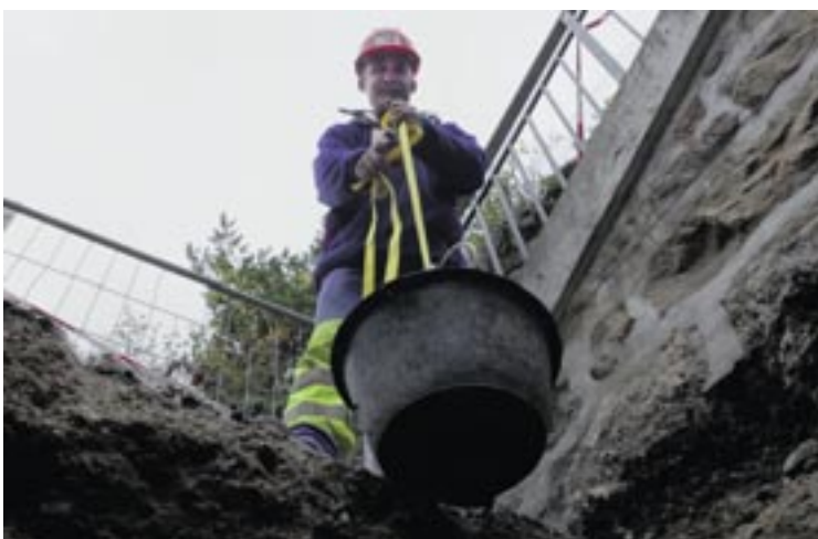
... préparation d'un emplacement pour un container enterré
