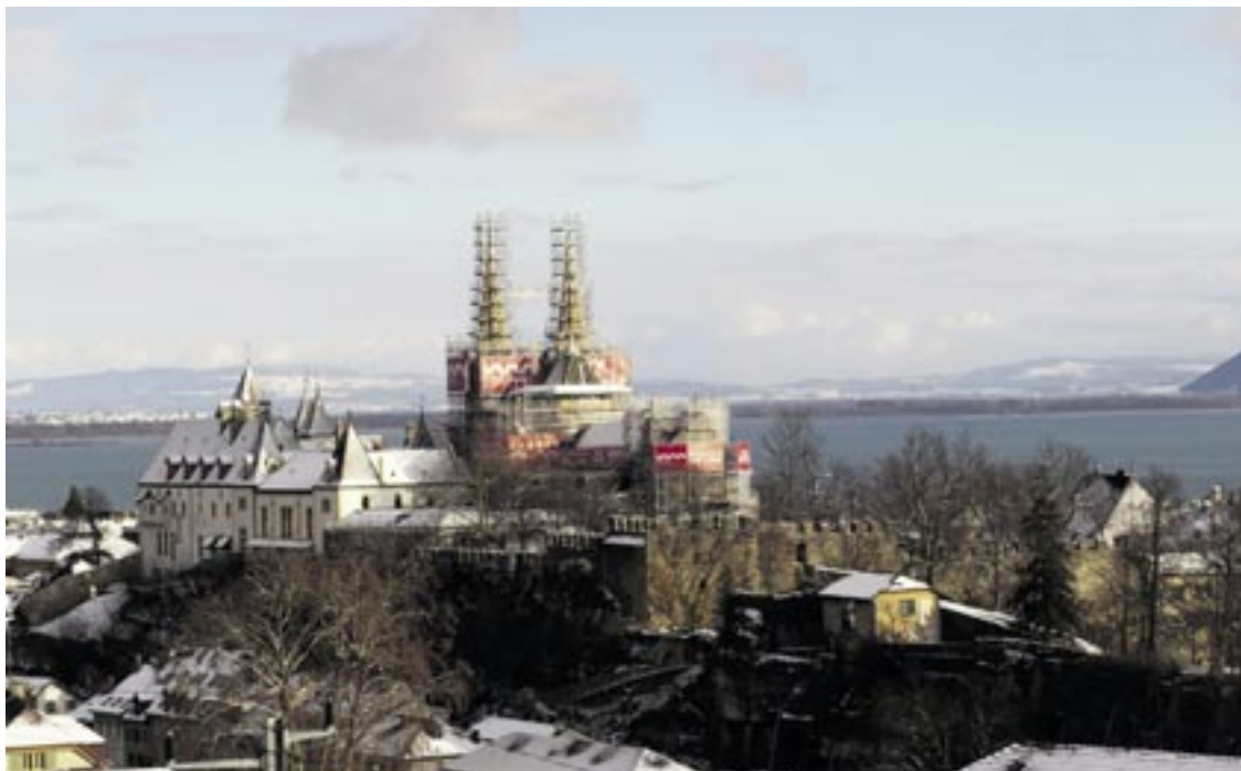
Si la météo le permet, Noël se fêtera sans bâche et échafaudage à la Collégiale.
