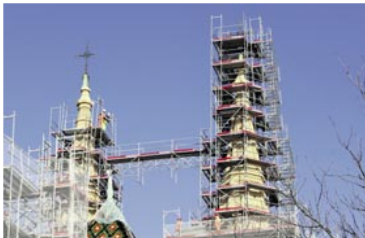
... démontage des échafaudages de la Collégiale
