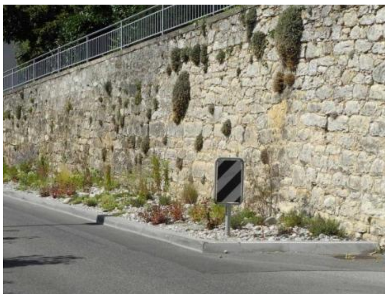
Figure 8: Avenue de Bellevaux, fosses végétalisées
