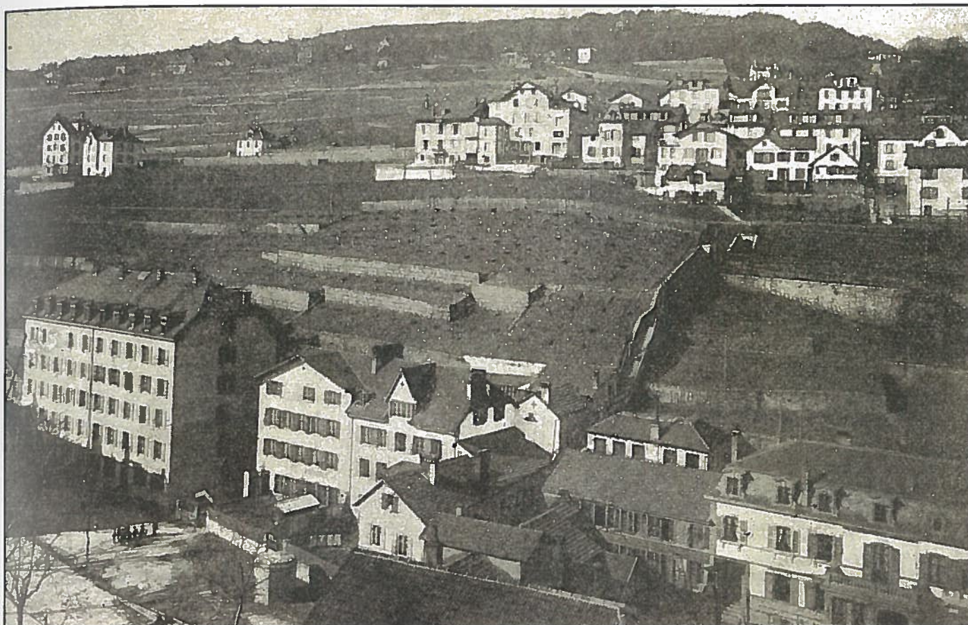
C'est un espace bien dégagé, aéré et ensoleillé qui est retenu pour l'édification du nouveau Collège (Ed. Quartier-la-Tente 1897, p. 307).
