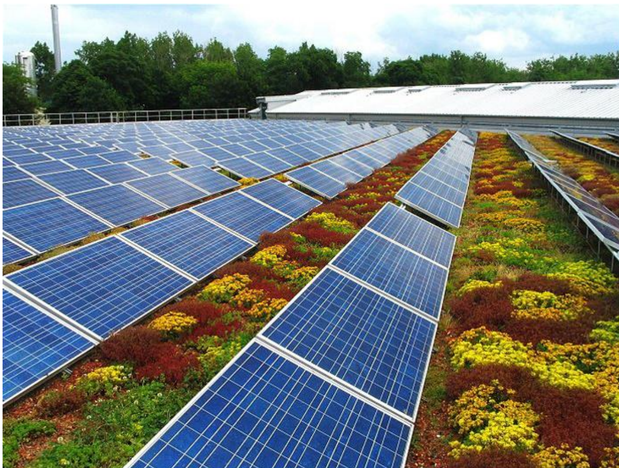
Exemple de panneaux photovoltaïques combinés à une végétalisation installés récemment à la Step de Seeland
