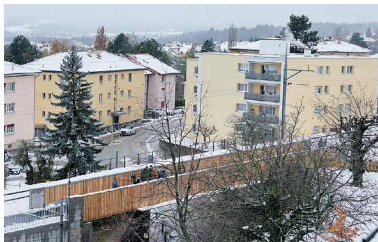
La passerelle enjambe le pont de la rue des Préels, pour rejoindre l'extrémité ouest de la commune. DAVID MARCHON
