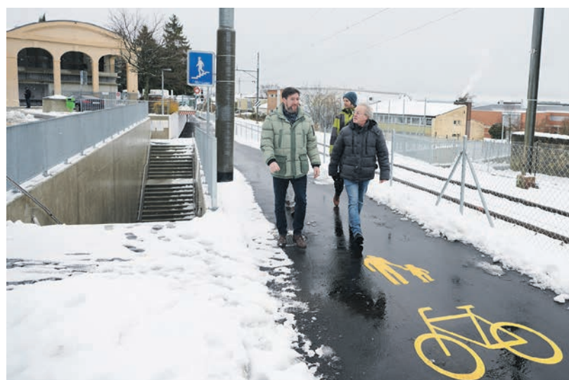
Un nouveau passage sous la voie de chemin de fer relie le collège des Safrières à la bibliothèque communale. DAVID MARCHON
