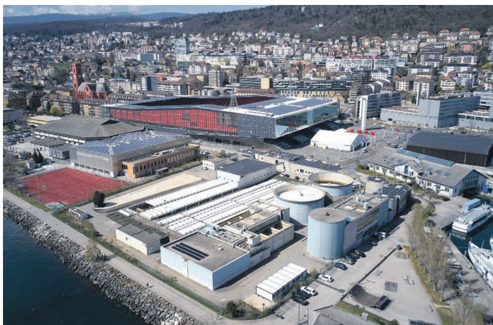
En travaux pour le traitement des micropolluants, la Step accueillera à l'avenir un pavillon destiné aux visiteurs.
