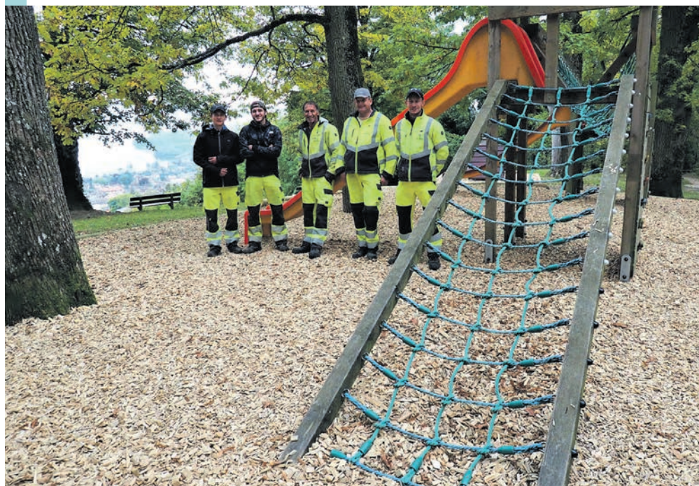
L'ancienne installation a été remise en état. THIERRY GUILLOD
