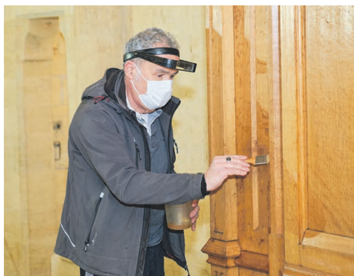
Le restaurateur de meubles Christian Schouwey cire la porte du sas ouest.
