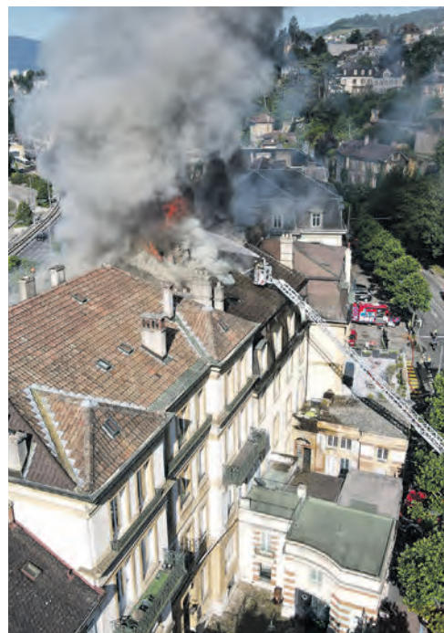
Les pompiers ont évité que le feu ne se propage aux immeubles voisins.
