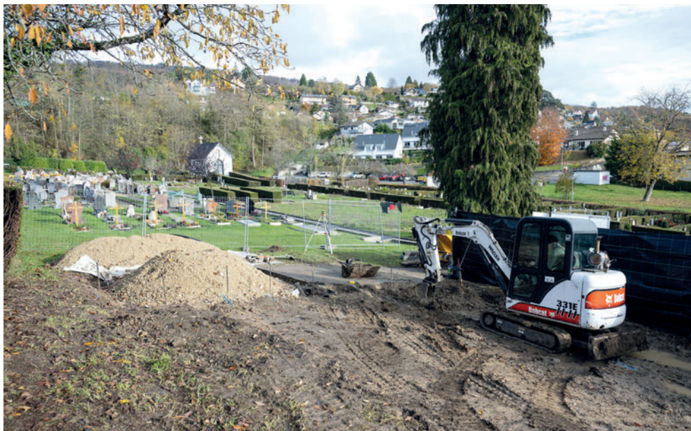
Visite sur le chantier du cimetière de Cormondrèche qui accueillera en fin d'année un nouveau quartier, entièrement réaménagé. PHOTOS: LUCAS VUITEL
