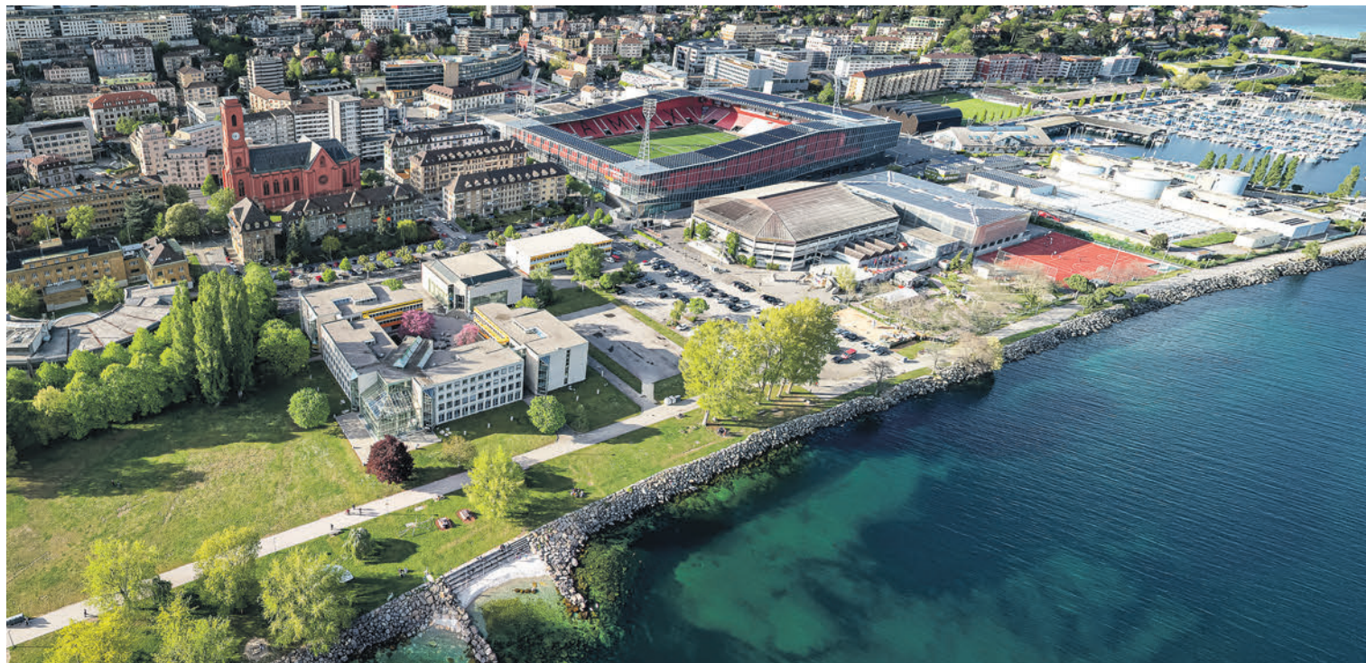
Aux Jeunes-Rives, à droite du bâtiment universitaire existant, plus de 8'000 m 2 accueilleront un «learning center» et des salles de cours. MARIO CAFISO
