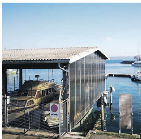
Une centrale énergétique en devenir.
