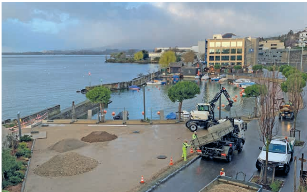
Les équipes de la Voirie et des Parcs et promenades étaient en plein travail lundi matin, afin de métamorphoser le port de Serrières en vue de la belle saison.
