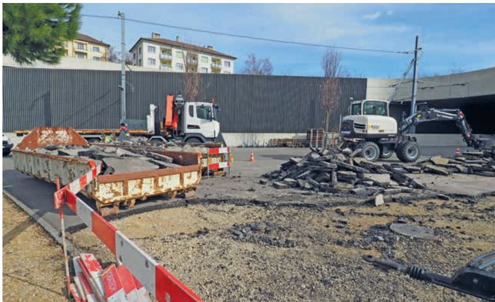
Les travaux ont démarré à la mi-mars par le dégrappage du goudron, qui sera remplacé par une zone mêlant gravier et gazon.
