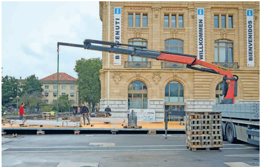
La construction des tentes de Capa'cité est en cours à la place du Port et ses environs pour l'ouverture prévue lundi. DAVID MARCHON
