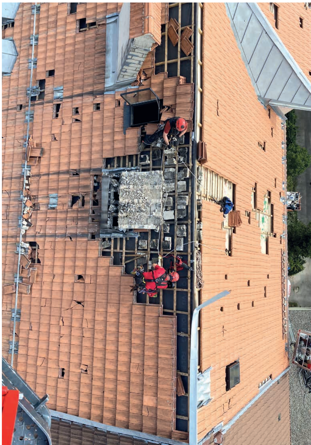
Un membre du GRIMP de Neuchâtel et son collègue chaux-de-fonnaire sécurisent un toit sur un immeuble de La Chaux-de-Fonds. Une mobilisation qui s'est poursuivie jusqu'à la mi-août.
