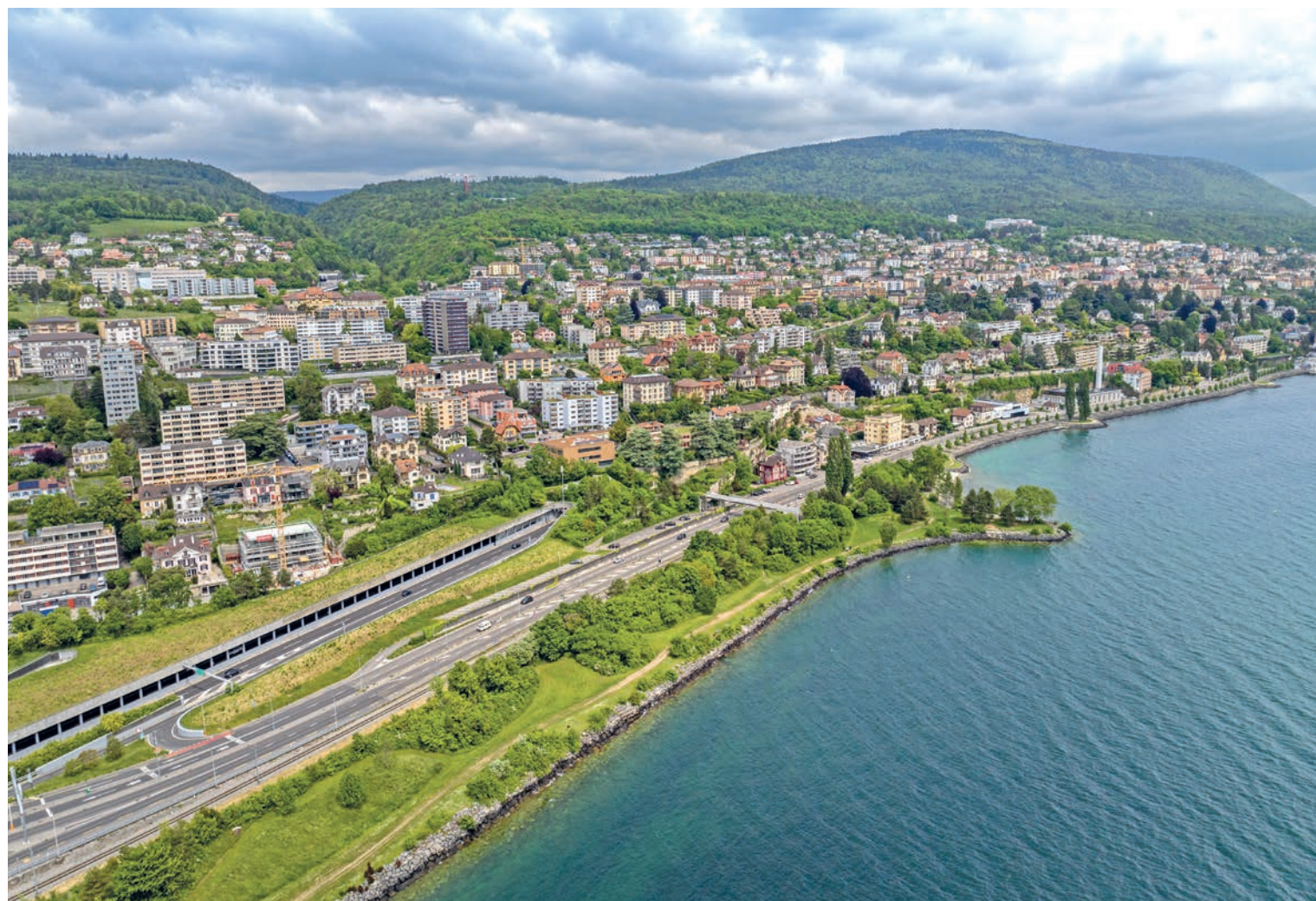
D’ici 15 ans, une grande part des bâtiments de la capitale cantonale seront chauffés par un réseau à distance alimenté par l’eau du lac. VISTADRONE
