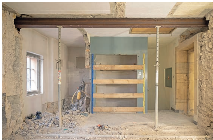
Une partie des murs de séparation des 24 cellules sont détruits pour permettre de réaménager de nouveaux espaces.
