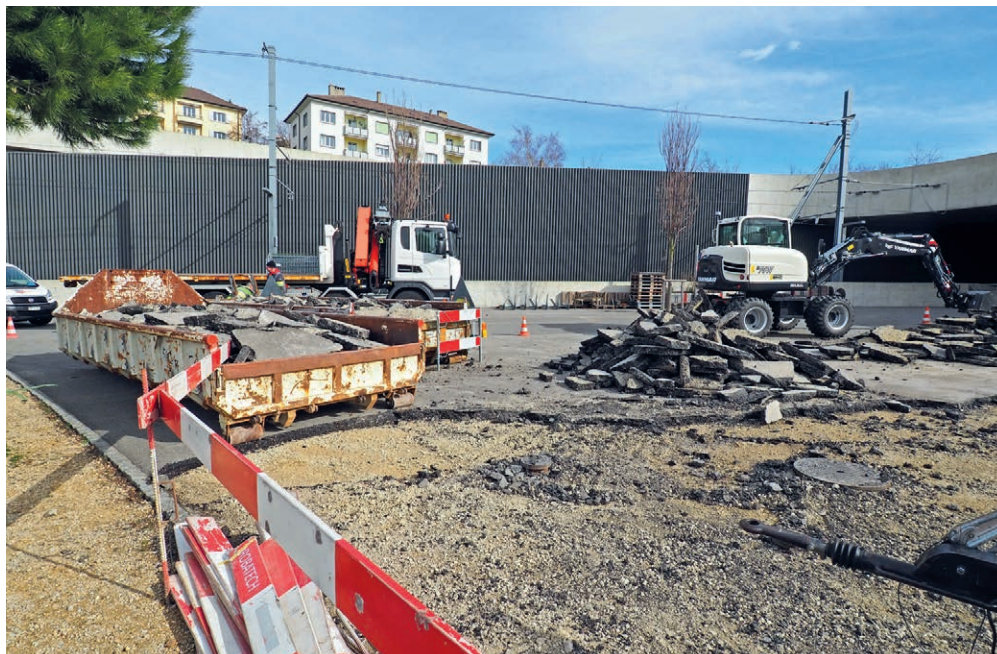
Le groupe vert'libéral salue le fait que la Commune supprime des surfaces bitumineuses au profit de sols perméables, comme ici à Serrières.
