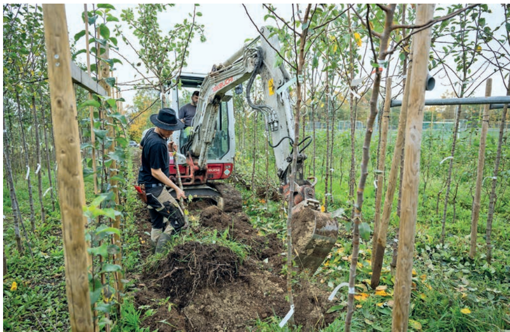
Dès que la pelle mécanique butte sur les racines, elle s'arrête pour les préserver en vue d'une prochaine plantation dans un verger.
