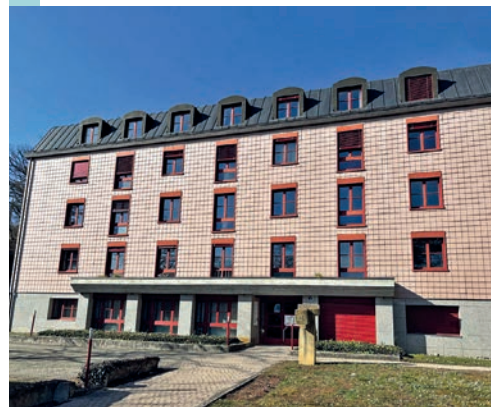
Le bâtiment du Verger-Rond 2.
