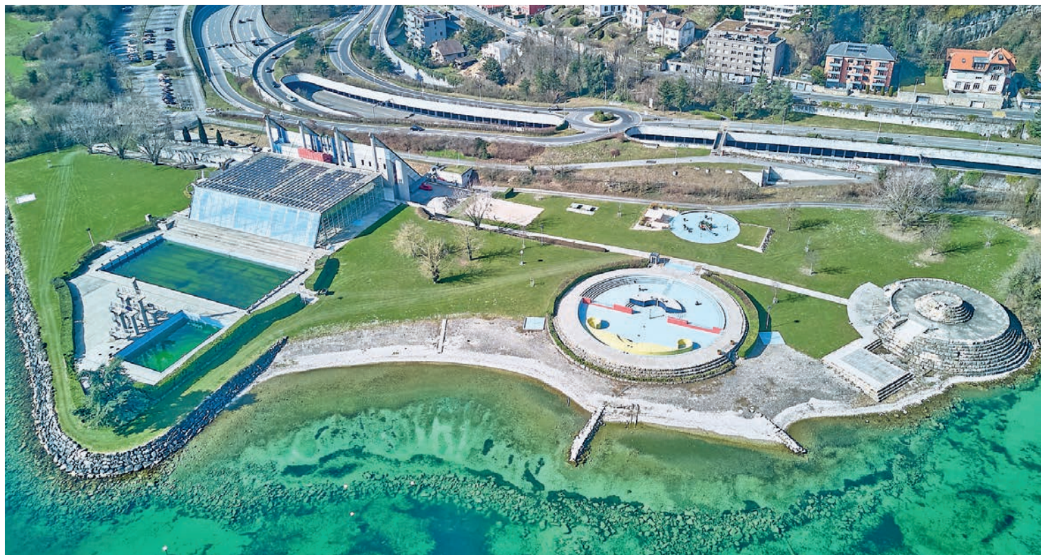
Le Conseil communal souhaite maintenir la qualité du site, dont plusieurs équipements de baignade sur le périmètre extérieur n'ont pas été assainis ou modernisés depuis leur mise en exploitation en 1990. BERNARD PYTHON
