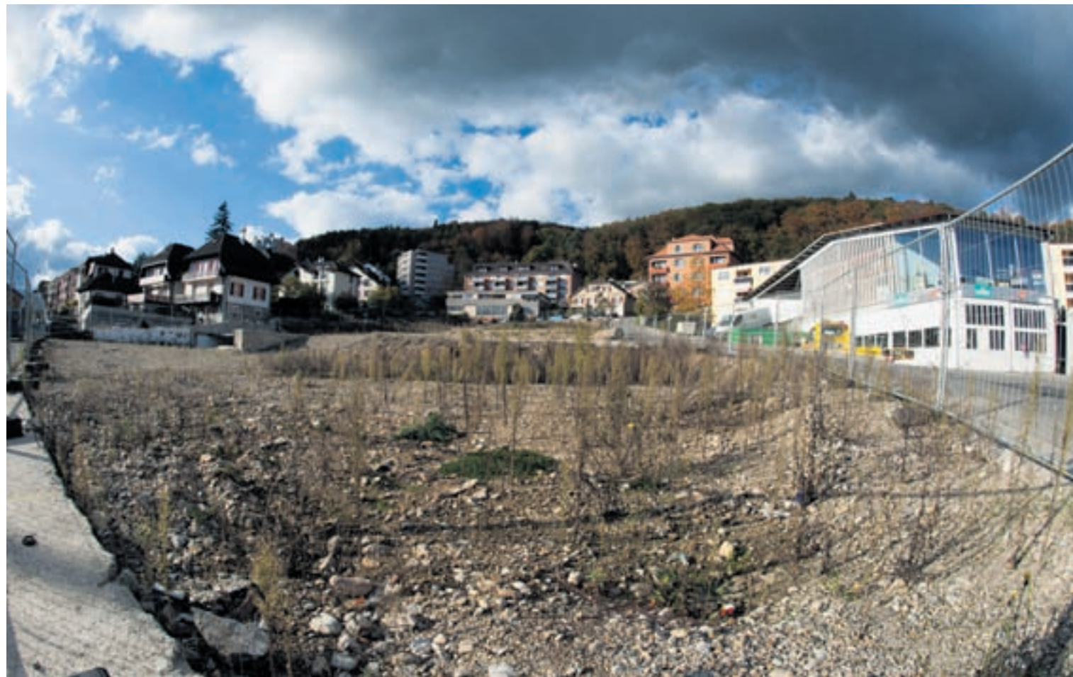
Trois immeubles d'habitation occuperont à terme la petite friche industrielle, sise à la rue de Bourgogne à l'ouest du chemin des Brandards.
