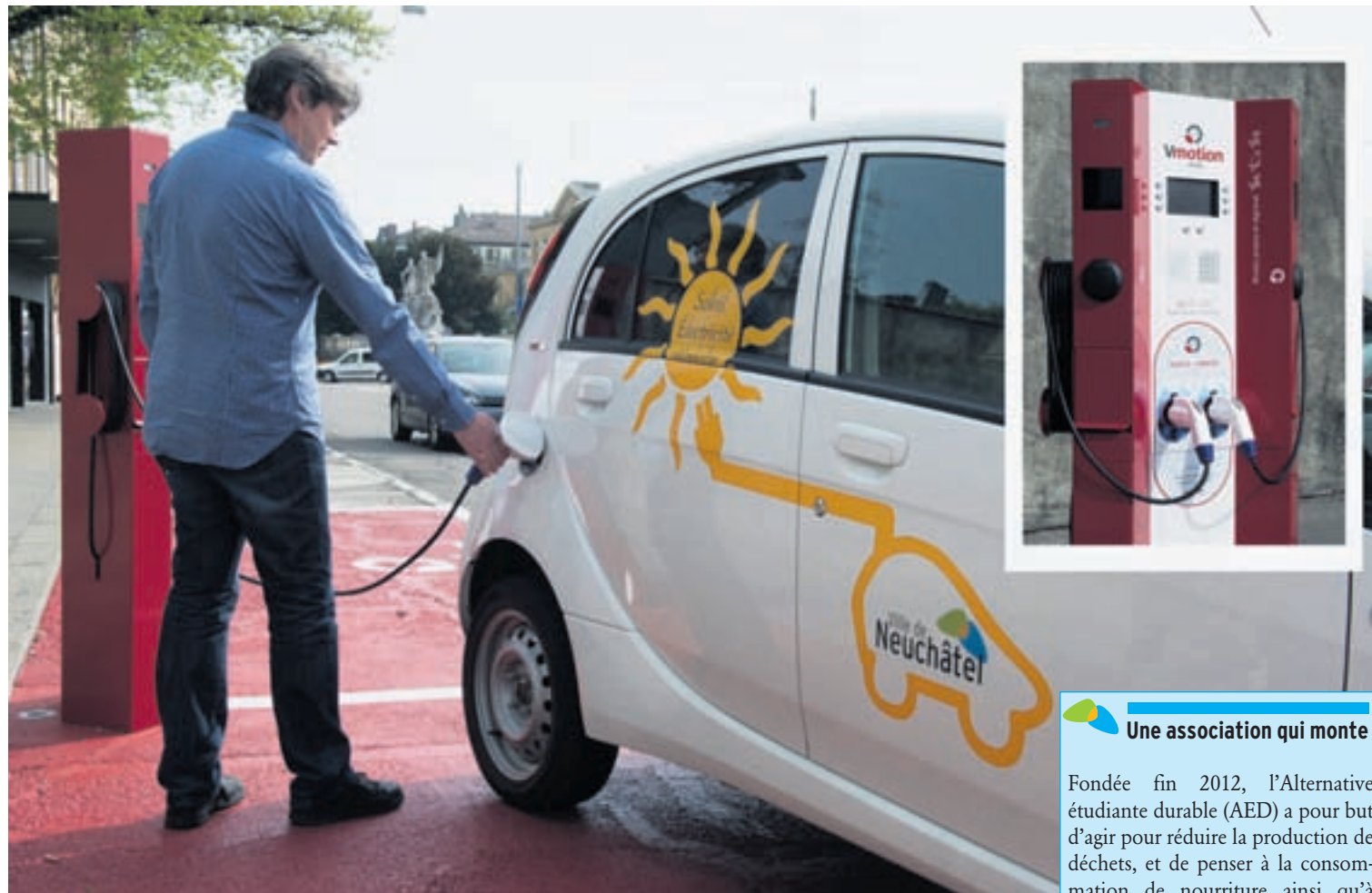
La borne de recharge pour véhicules électriques est désormais fonctionnelle à la place Alexis-Marie-Piaget.
