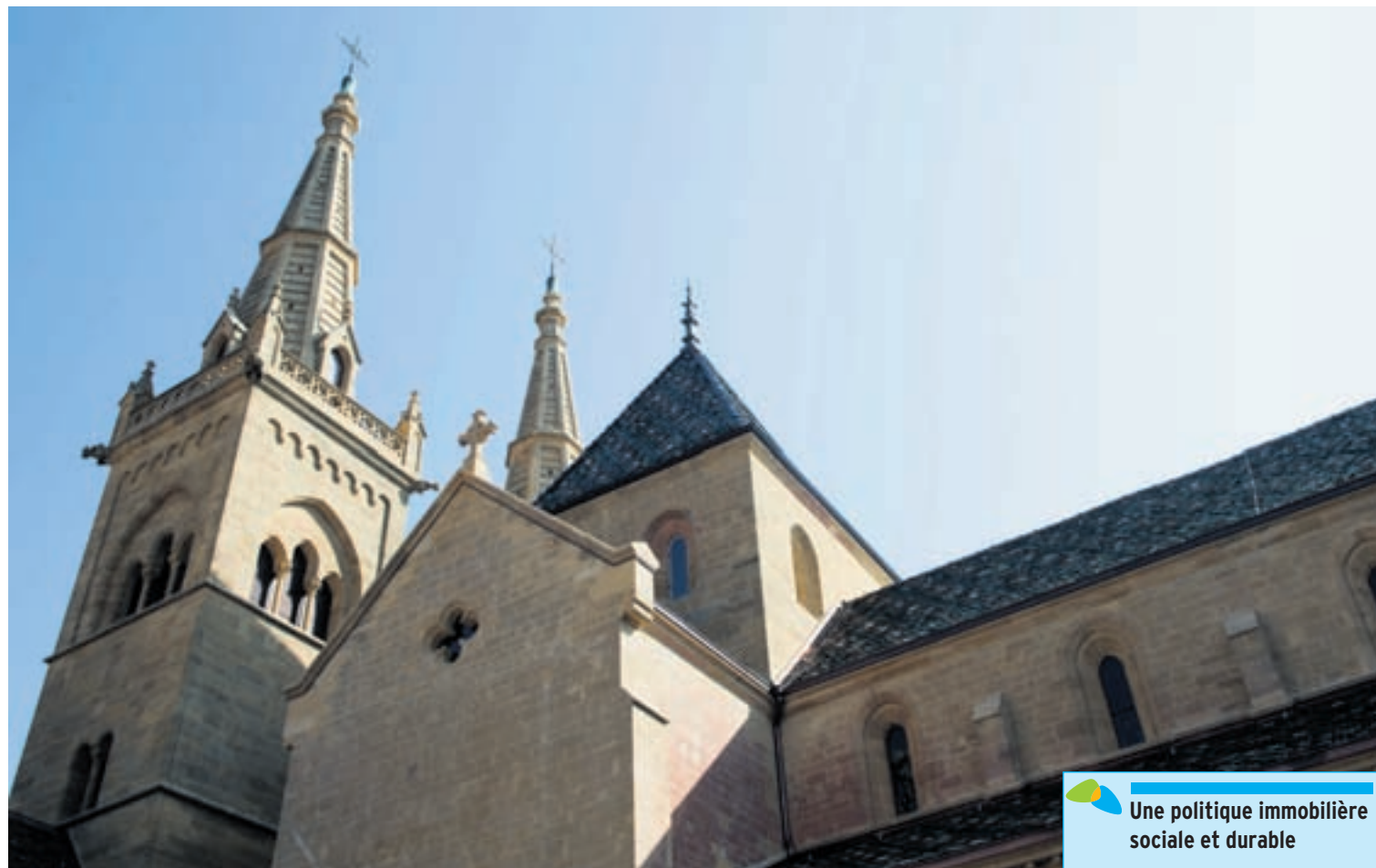
L'ensemble des partis s'est réjoui de la qualité des travaux de la première étape.
