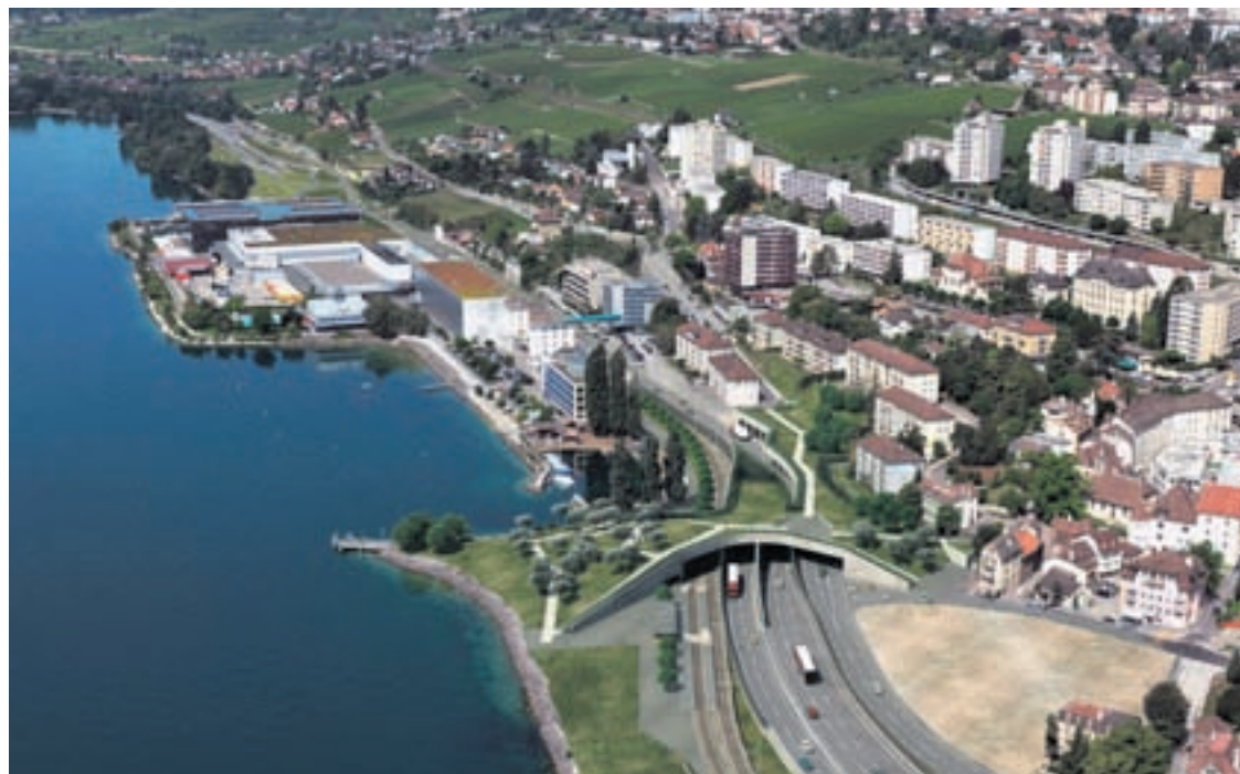
La tranchée couverte du tunnel de Serrières reliera à horizon 2015 le bas du quartier aux rives du lac. • Photomontage: Rhinocéros
