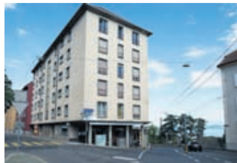
L'espace Coworking-Neuchâtel se situe à la rue des Sablons 2, à cinq minutes à pied de la gare de Neuchâtel.
