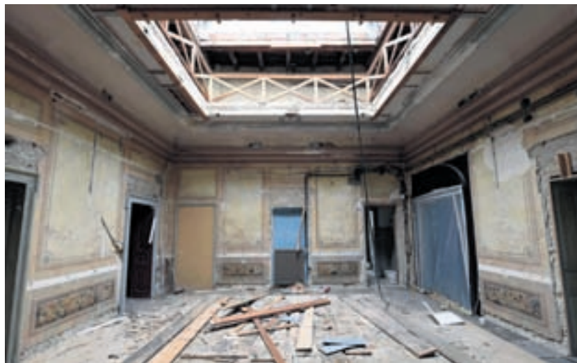
La verrière de la villa de Pury sera réhabilitée. • Photo: Alain Germond
