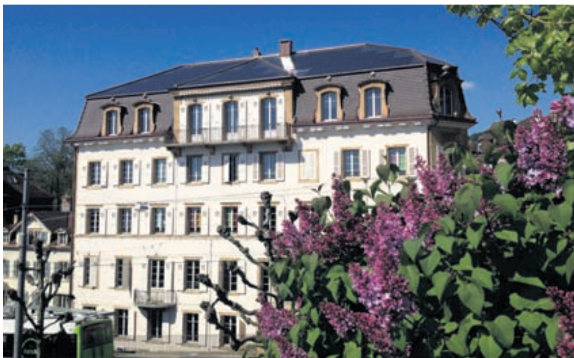
La centrale photovoltaïque coiffant l'Hôtel des Associations a reçu une distinction nationale. • Photo: Viteos
