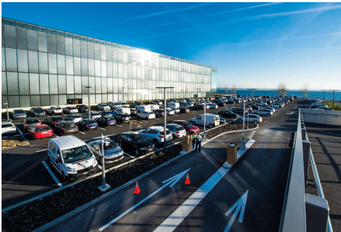
Ouvert depuis cet été déjà, le parking, situé à proximité de la piscine de Serrières, entre en fonction lundi prochain sous le régime P+R. • Photo: Stefano Iori
