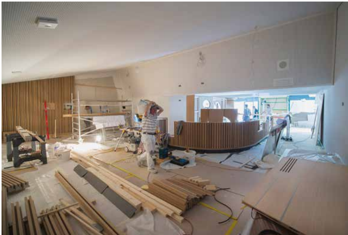
Les travaux vont bon train pour terminer à temps le nouveau hall d'entrée de l'Apollo. Plus grand qu'avant, il accueillera un bar. • Photo: Stefano Iori
