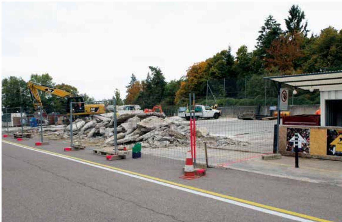
Des dépôts provisoires seront aménagés au fil du chantier pour garantir toute la gamme des déchets récoltés. • Photo: Stefano Iori
