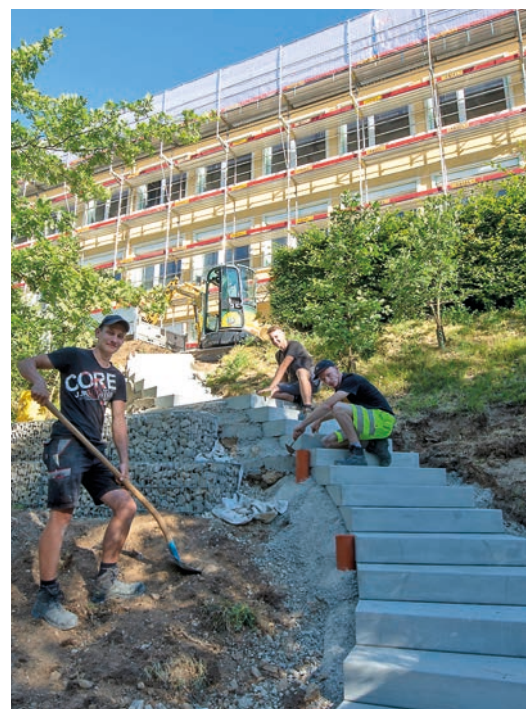
Le nouveau Carambole est directement relié à la place de jeux de la plaine du Mail par un escalier construit par deux apprentis du Service des parcs et promenades, épaulés par un jeune maçon diplômé.
