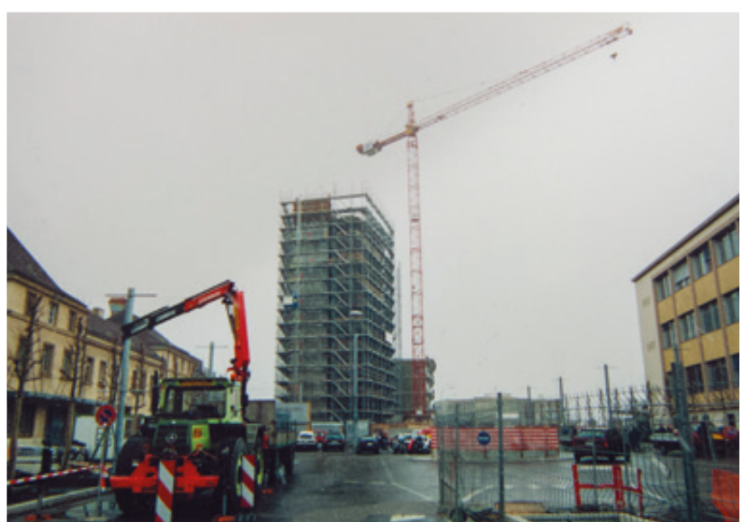
Symbole du multilinguisme national, la tour de l'OFS en construction vers 2003, avant de se parer de son habit de verre.
