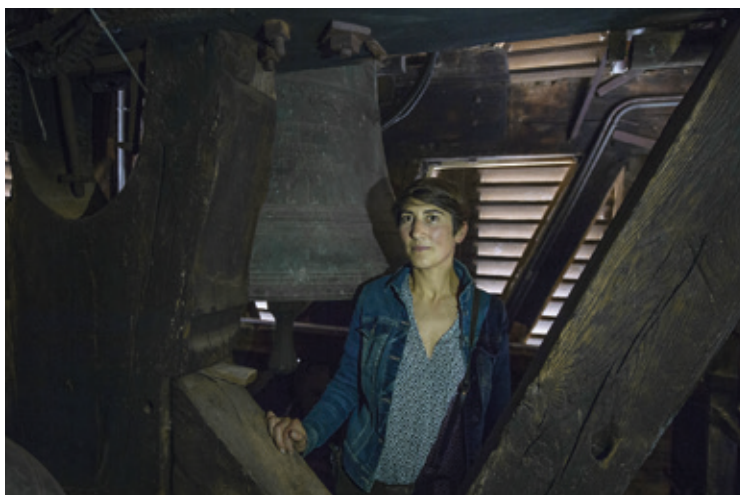
L'architecte Anne Dupraz fait visiter la tour sud. L'un des objectifs des travaux est d'empêcher la charpente des cloches de taper contre le mur de la tour.
