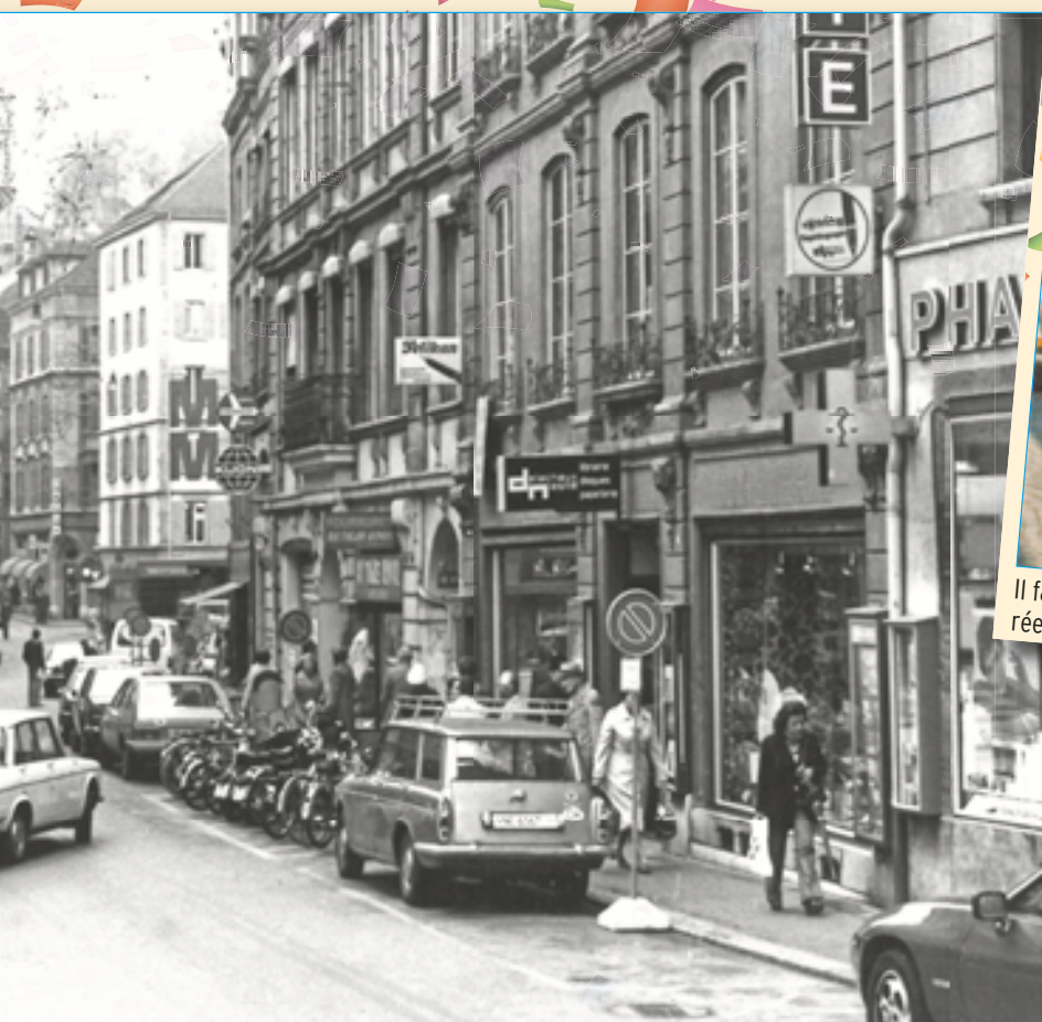
itairement dévolu à la circulation et au parcage des véhicules motorisés.
