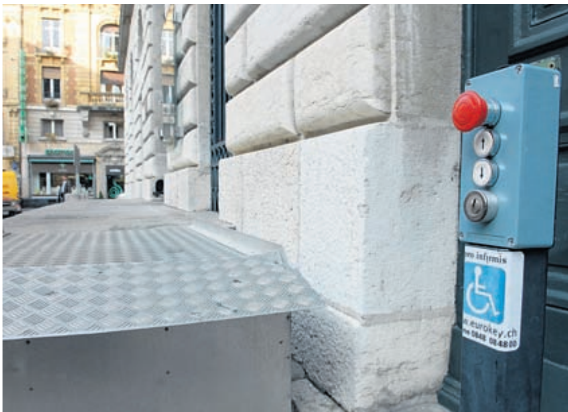
La plate-forme élévatrice de l'Hôtel de Ville fait partie des 850 installations suisses qui fonctionnent avec le système Eurokey.
