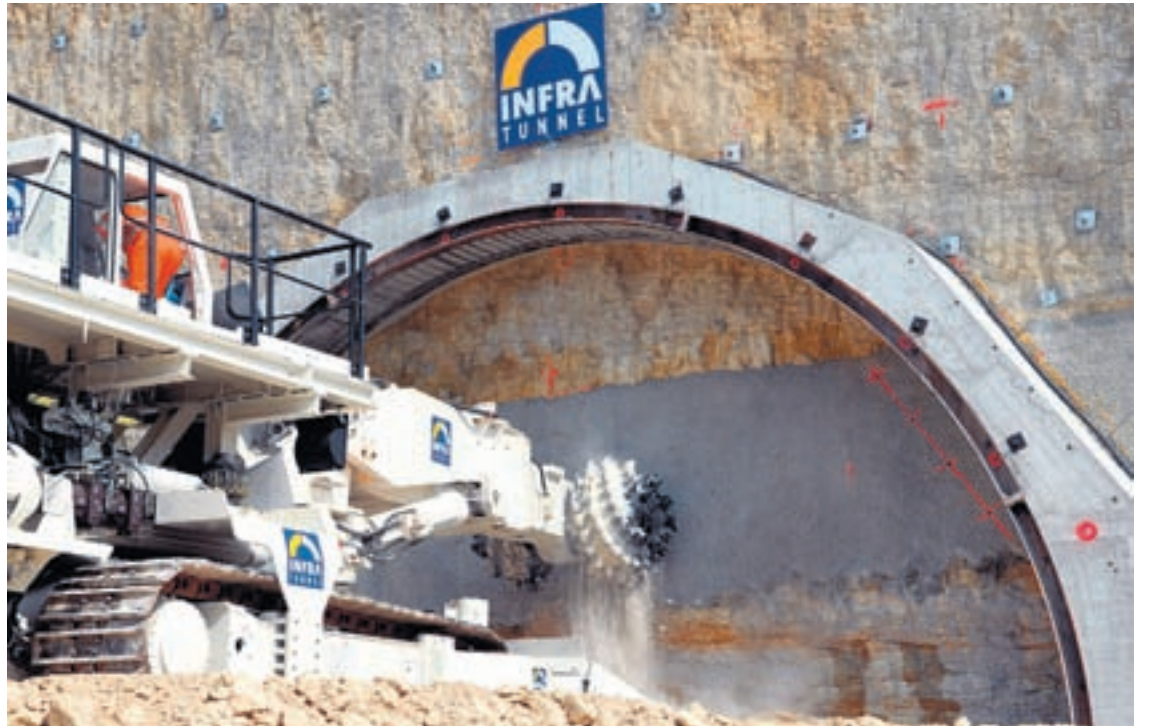
Une première haveuse a attaqué en début de semaine le percement de la calotte du tube nord du tunnel autoroutier de Serrières.
