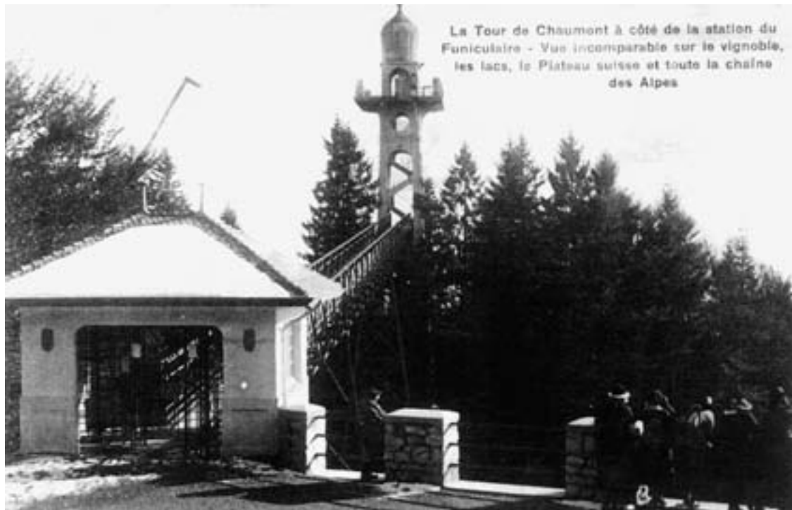
La Tour de Chaumont et son porche d'entrée d'origine. A son sommet, socle et coupole sont bien visibles.
