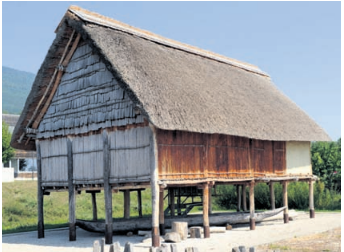
Dans les villages palafittes, certaines maisons étaient construites sur pilotis pour éviter la crue du lac.
