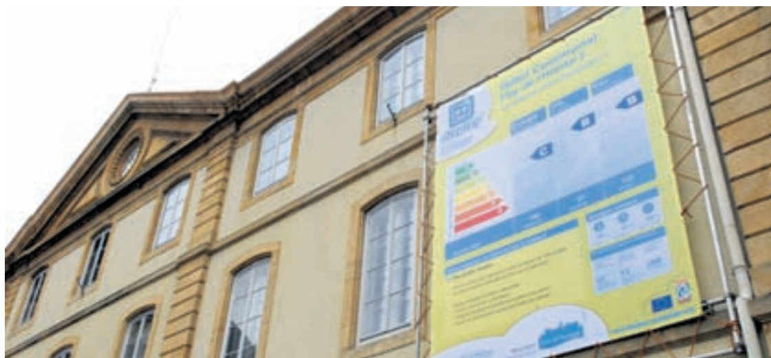
La Ville de Neuchâtel est une adepte de l'étiquetage énergétique de ses bâtiments. C'est un excellent outil dans les domaines de la sensibilisation et du diagnostic énergétique.
