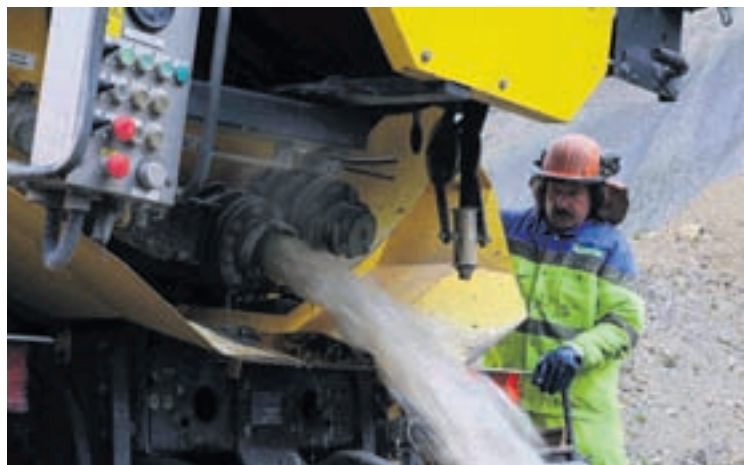
... évacuation d'eau propre
