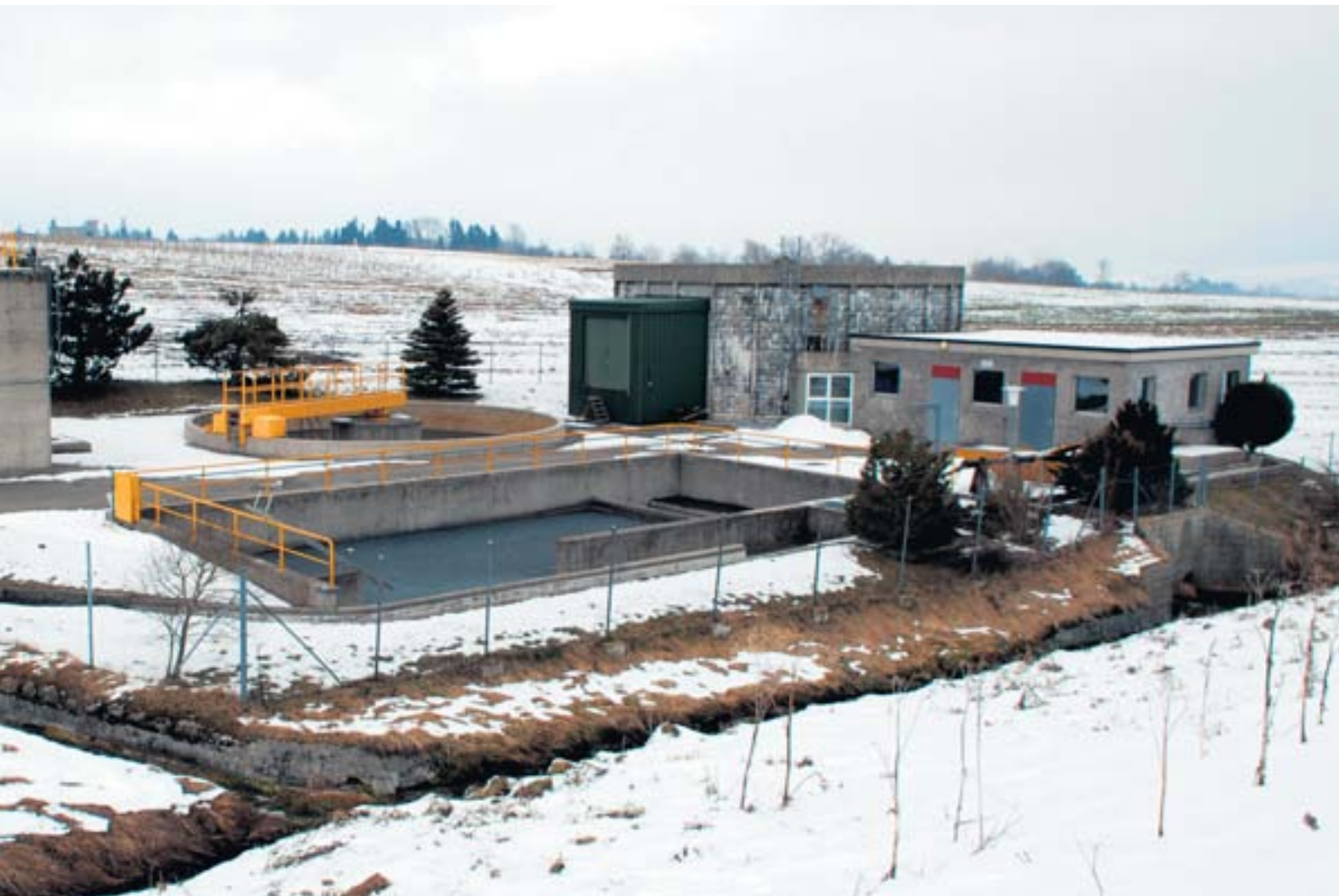
Optimisme le raccordement des STEP de quatre communes du Val-de-Ruz à celle de Neuchâtel (ci-dessus la STEP de Coffrane)
