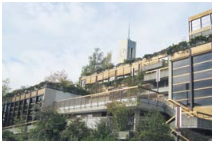
Les bâtiments d'une mauvaise qualité thermique (ici le collège du Crêt-du-Chêne) sont les premières cibles de la nouvelle loi cantonale sur l'énergie. Une stratégie originale, logique et particulièrement efficace leur imposera une meilleure efficacité! • photo: sp
