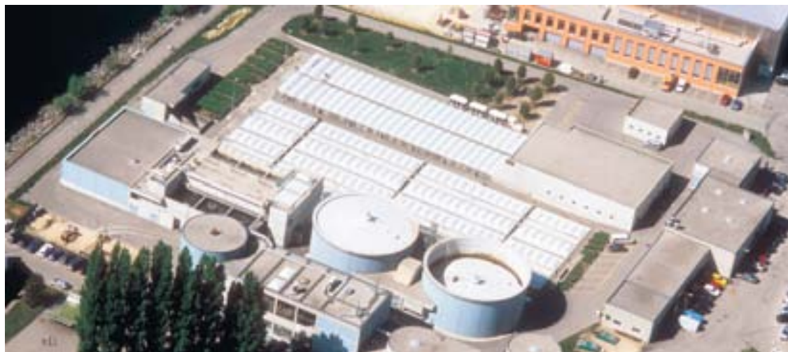
La STEP de la Ville de Neuchâtel (ci-dessus) traitera les eaux usées de trois STEP du Val-de-Ruz en fin de vie.
