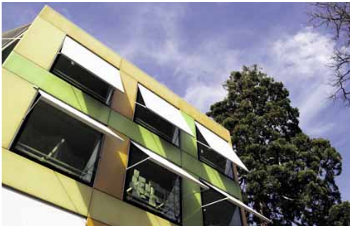
Le stand de la Ville mettra à l'honneur les bâtiments peu «énergivores», comme le nouveau collège de la Maladière.
