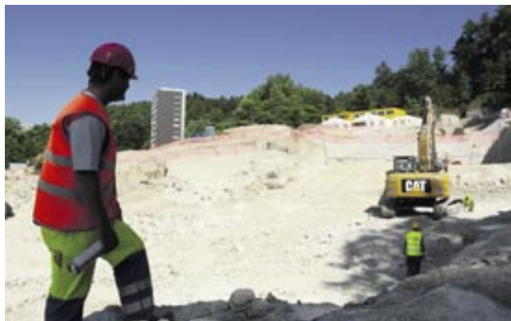
Bonne nouvelle pour les habitants du quartier des Cadolles: les travaux de terrassement - et les nuisances qui les accompagnent - prendront fin en juillet.
