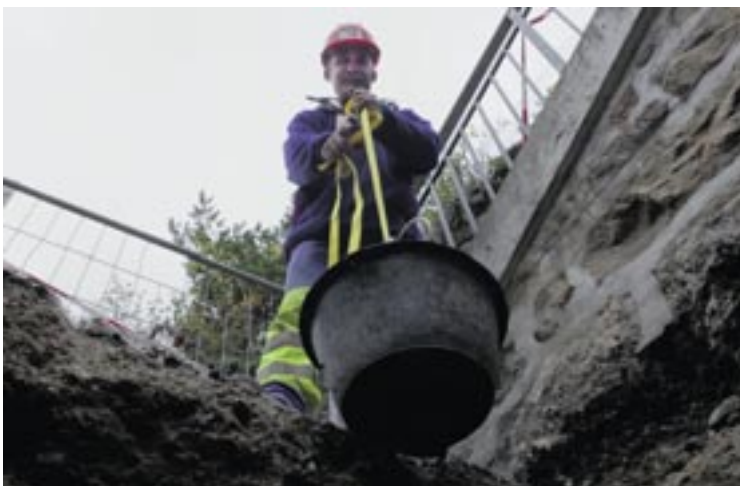
... préparation d'un emplacement pour un container enterré
