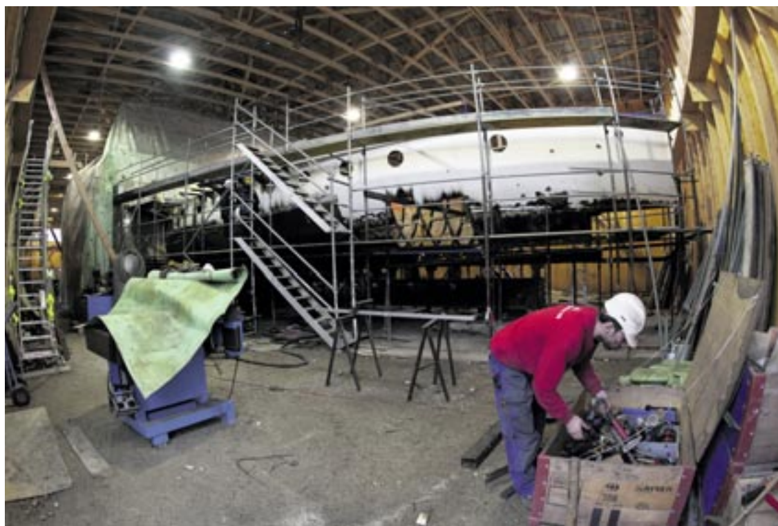
Les travaux de réfection de la coque sont en passe de s'achever. Dans un mois, les ouvriers s'attaqueront à la partie technique.
