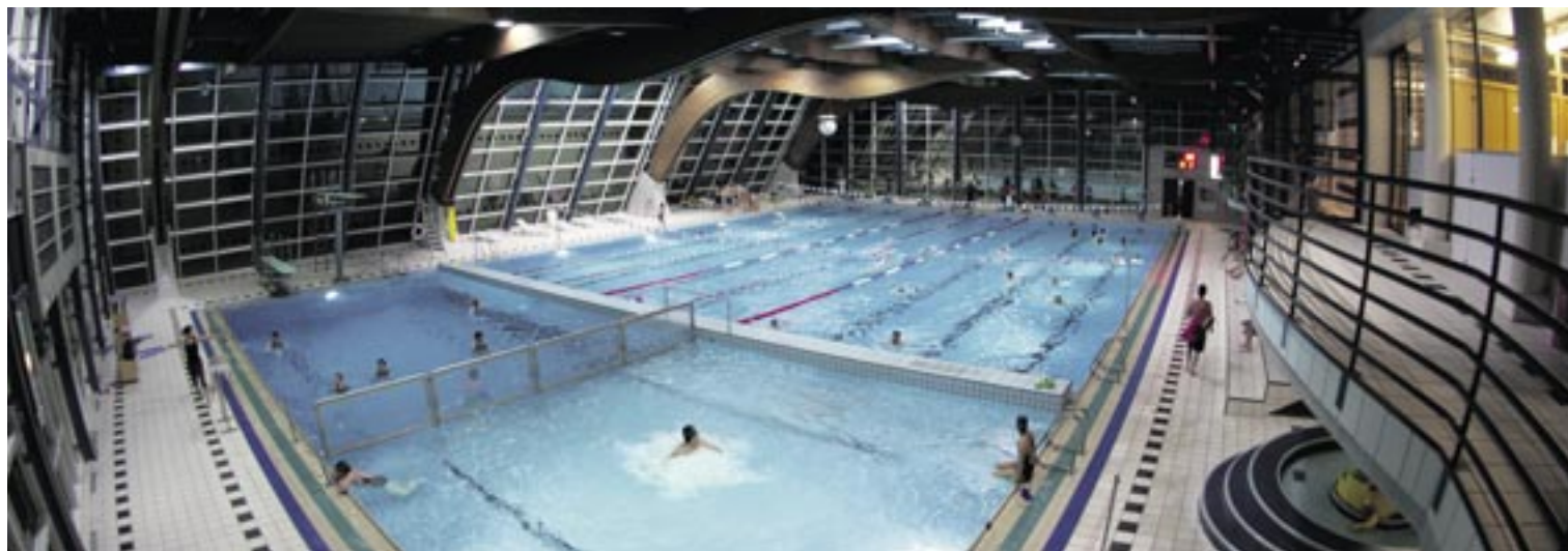
La commune prévoit d'investir dans un projet qui permettra de réduire la consommation d'énergie des piscines du Nid-du-Crô.
