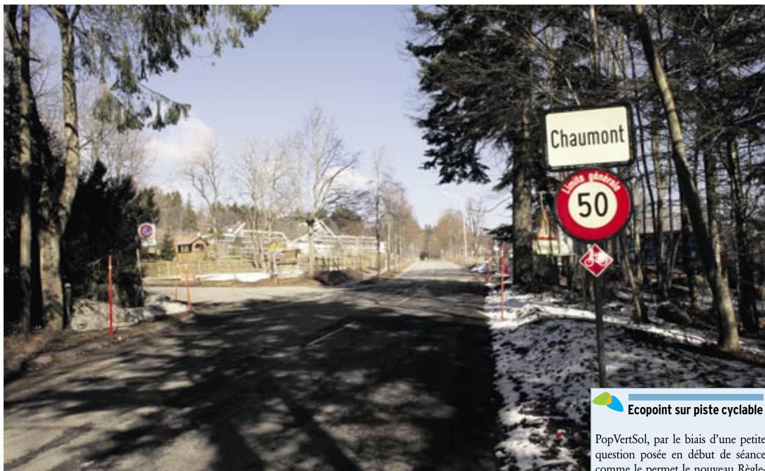
Des travaux de rénovation des routes seront entrepris à Chaumont, dans le cadre de l'entretien du domaine public.
